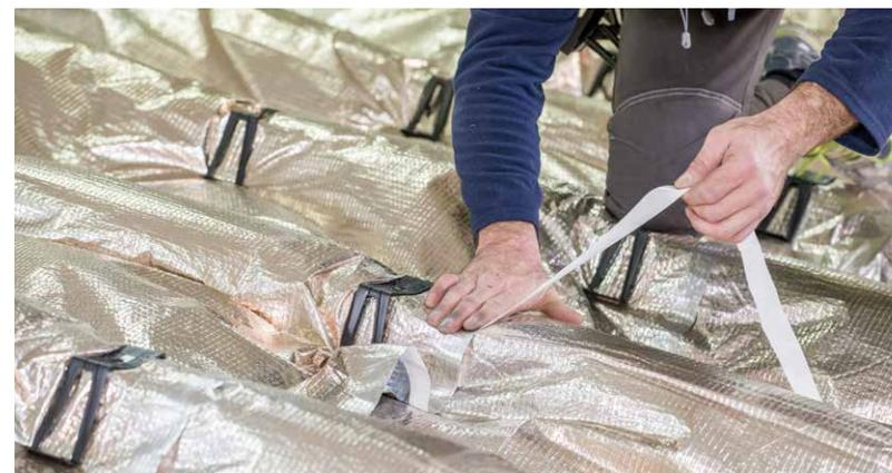
En périphérie de l'isolation, réaliser un retour d'isolant de 50 mm au minimum sur lui-même.
