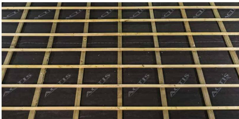
**2** Tendre correctement l'isolant et l'agrafer en périphérie tous les 50 mm au minimum sur un support bois (chevron, solive, entretoise...). Utiliser des agrafes galvanisées ou inox de 14 mm à 25 mm selon l'isolant.
